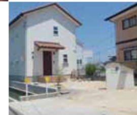
▼施工前。広い敷地に門柱が立っているのみ
