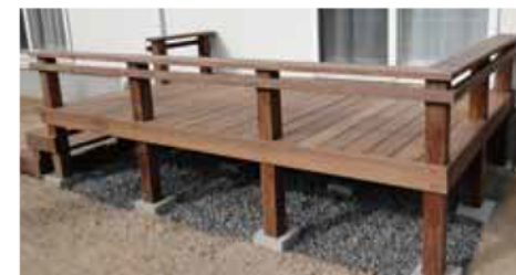
▲リビング前に設けたウッドデッキ。床下には碎石を敷設。今は階段だが、将来は足の不自由なお義父さまのため、車椅子での出入りもできるようスロープにする予定
