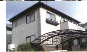
施工前の外観
